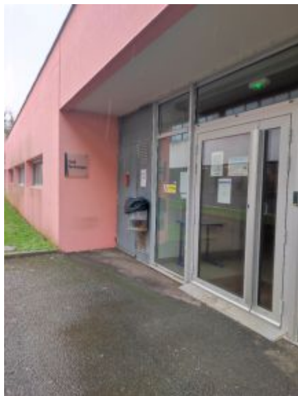
Cheminement extérieur accessible.
