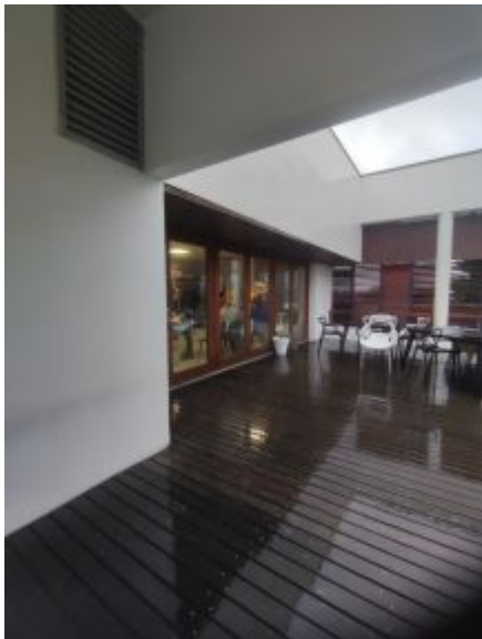
Cafétéria accessible. Paroi vitrée à sécuriser.
